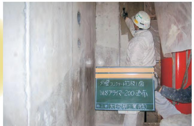
※RC面の新築・改修で既存塗膜がない場合 → WSプライマー200(溶剤)
