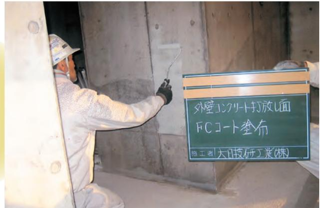
※全面塗りの場合はローラー・エアレスで、部分補修の場合はスポンジ等で施工調整してください。
