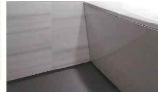
床と壁 幅木高さ約20mm。 壁と幅木の段差0mm。
