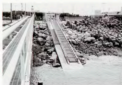
完成した斜路
