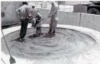
タンク基礎リング内の土盛り転圧
