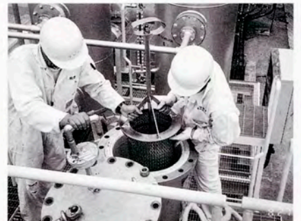
バケットストレーナーの開放検査
