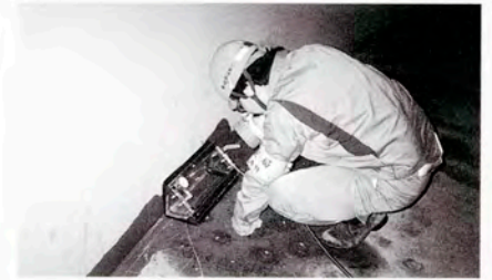
タンク内部溶接線の真空検査
