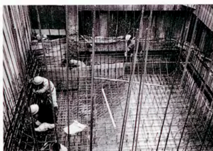
水消火専用用水池新設工事
