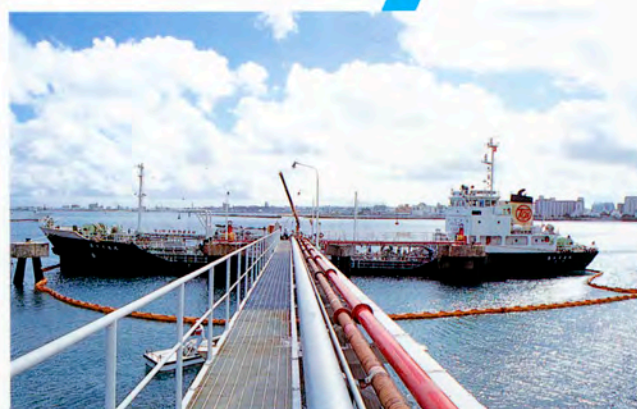
燃料搬入中の棧橋配管と天竜丸
