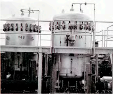
搬入ラインのフィルターセパレーター
