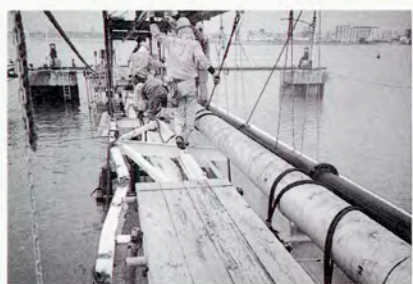
燃料配管の取替作業
