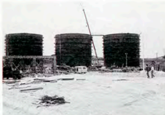
主タンクの組み立て終了
