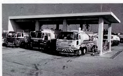
充填場にてレフューラーへ給油
