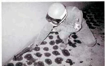
開放検査時の金槌打検査
