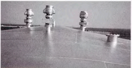
固定式屋根と換気孔
