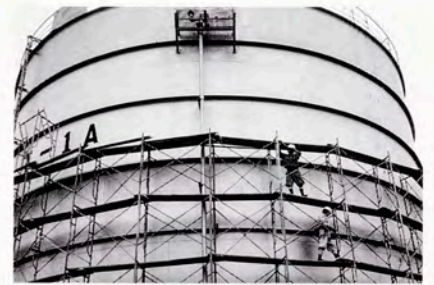
タンク外面塗装時の足場組立高所作業
