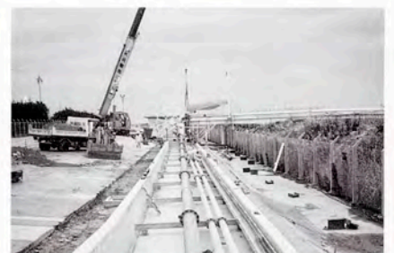
埋設配管地上化工事
