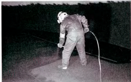
タンク内部下塗り
