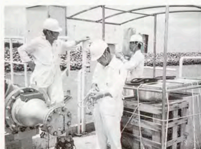
栈橋先端部の作業台の固縛
