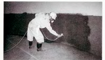
タンク内部側板の中塗り
