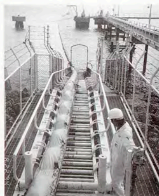
オイルフェンスの引き上げ
