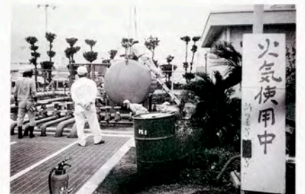
泡タンク設置工事での火気使用
