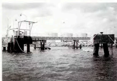
栈橋設備の全景
