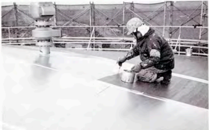
タンク屋根の外部中塗り
