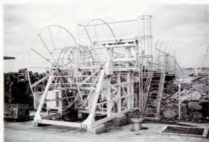
オイルフェンス巻取機の設置
