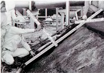
タンク犬走りのアスモル敷設
