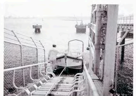
オイルフェンス展張船の引き上げ
