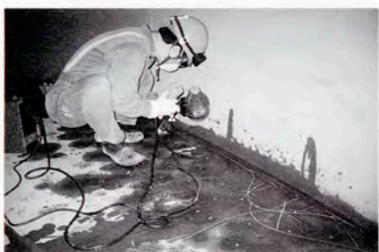
主タンク底板、溶接部の磁粉探傷検査
