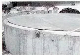
タンク底板の設置と溶接を終了
