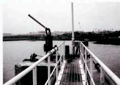
泡モニターノズルの新設
