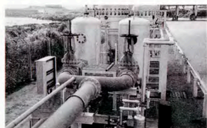
完成した2ライン化工事
