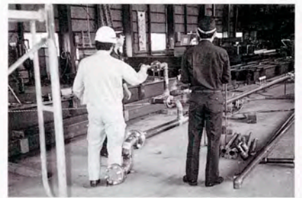
消防署立会いによる配管水圧試験
