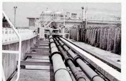
埋設配管の地上化工事
