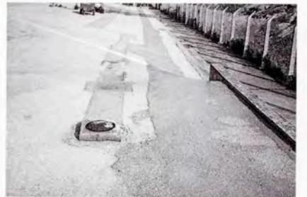
栈橋入口～充填場間の埋設配管部
