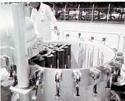
フィルターエレメントの交換
