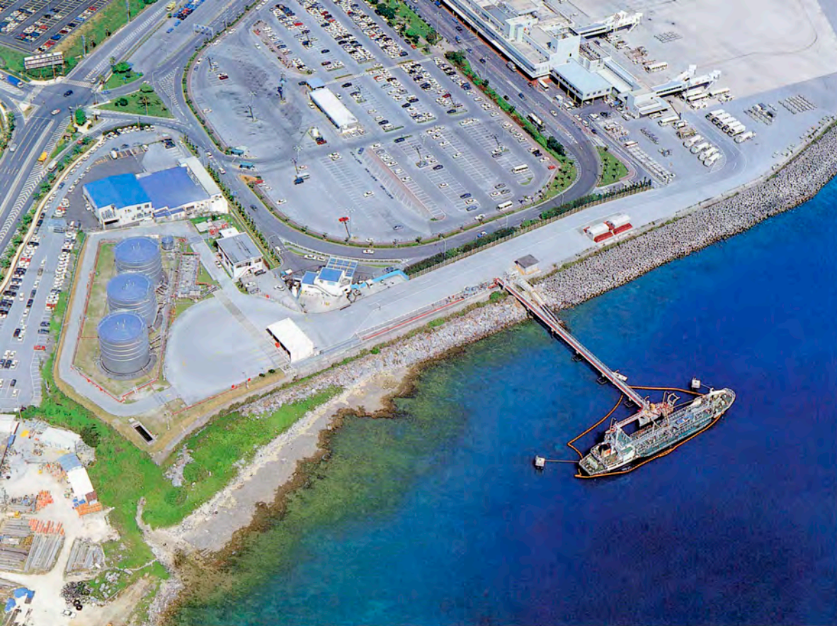
那覇空港内給油施設地区の全景
