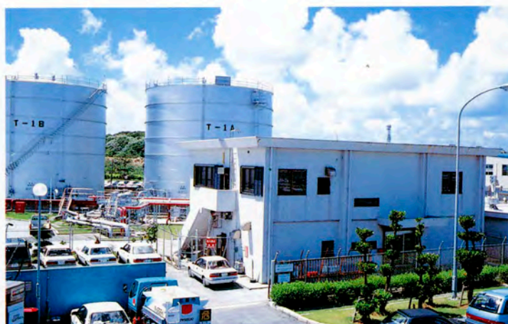
管理棟（事務室、中央制御室、分析室、倉庫）
