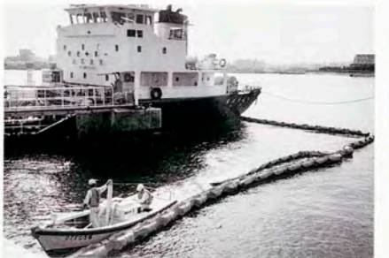
オイルフェンスの展開作業
