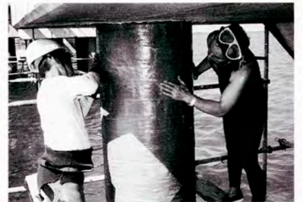
棧橋脚柱にペトロラタムテープを被覆
