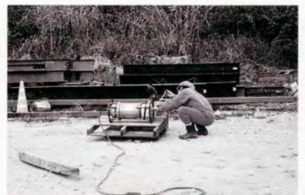
配管溶接部のX線検査
