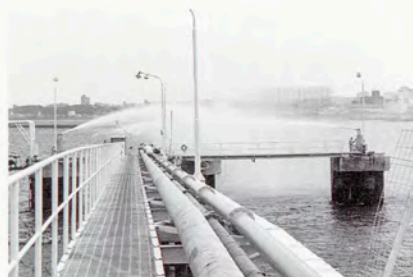
栈橋泡モニター放水訓練
