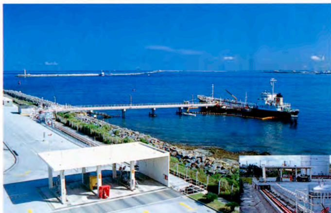
栈橋設備全景と着栈中の天竜丸
