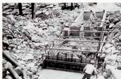
防波堤部の斜路建設工事
