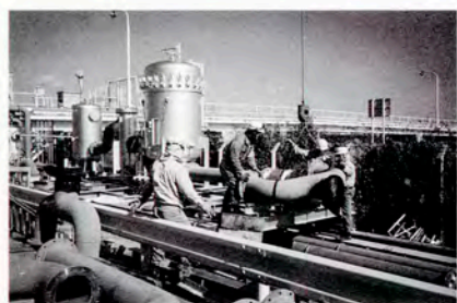
2ライン化の工事中
