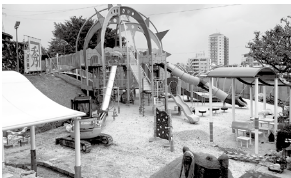
「浦添大公園整備工事(R5-2)」の現場で写真管理と安全管理を担当しました。
