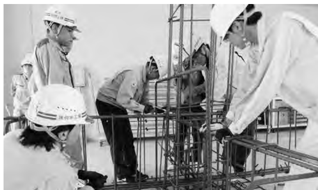
鉄筋組立から解体までを行った 支えられて無事修了できた」などの声があがった。
