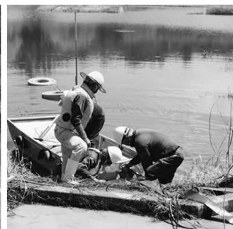
小型排水ポンプ設置作業(沖総局HPより)
