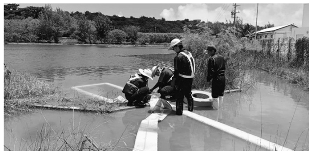
冠水箇所への吸い込み口設置(沖総局HPより)
