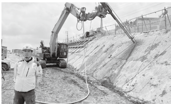
「令和6年度新川地区改良工事」の現場で写真管理・安全管理などを行っています。
