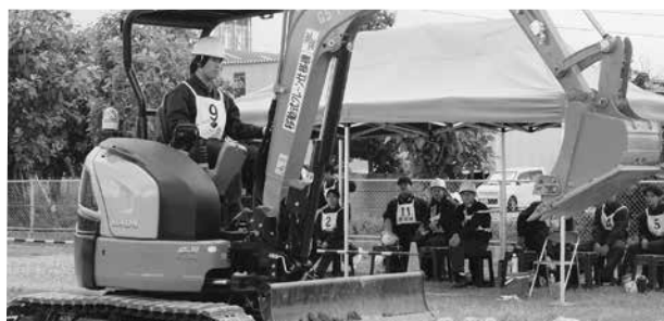
沖縄市の実技でバックホーを操作
