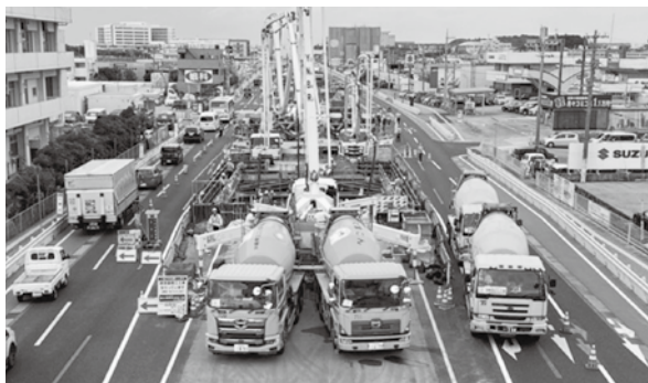
初めての現場「令和5年度小禄道路橋梁基礎工(P44)工事」では、主に写真管理と安全管理を担当した
