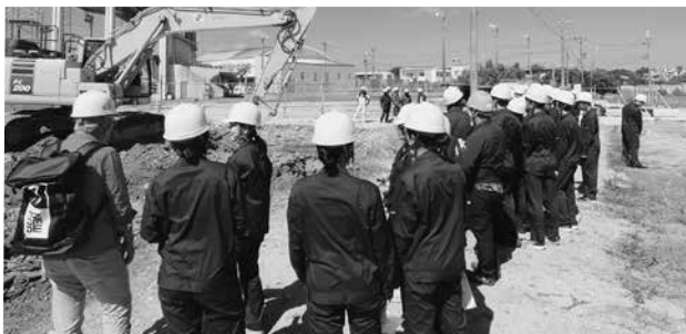
地盤調査の工程を見学した(建築科)
