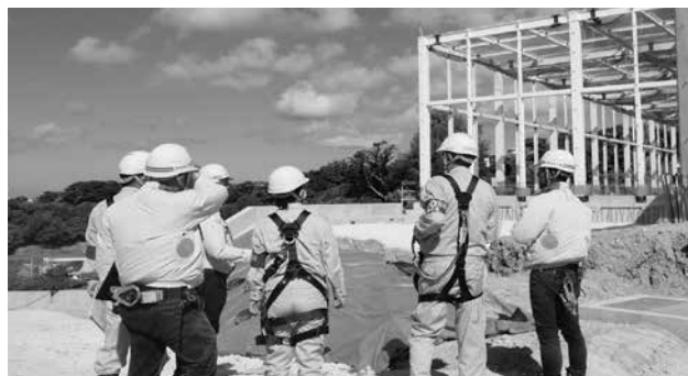
大型クレーンが稼働する現場を点検した
