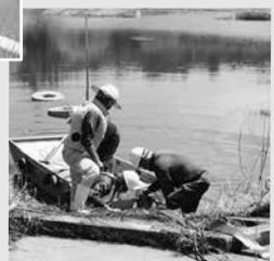
小型排水ポンプ設置作業を行った(右:沖総局HPより)
