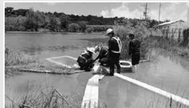
北大東村の冠水被害で吸い込み口を設置して排水支援(左:沖総局HPより)
