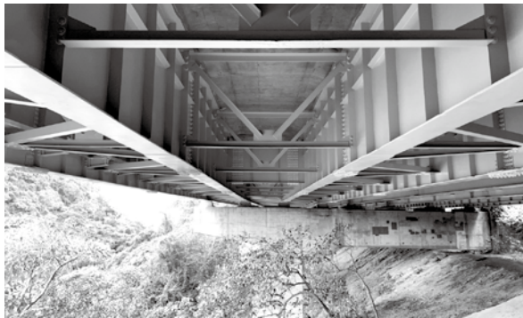
担当した現場 「橋梁補修工事」
