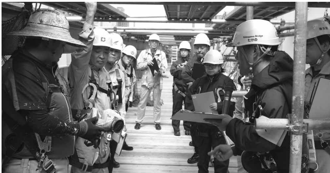
吊り足場の現場を確認する仲本支部長ら
