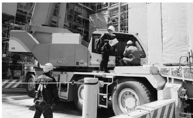
中部管内での現場でクレーン車内を確認
