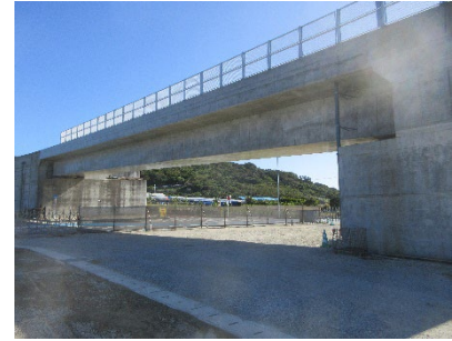
R4 南部東道路現場技術業務委託 （その2） （南部土木事務所）
