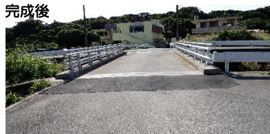
古島線 1 号橋修繕設計委託業務 （令和 3 年度）（八重瀬町役場）
