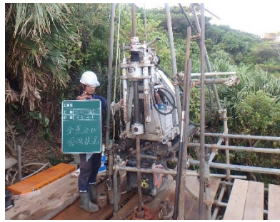
ボーリング調査 久米島一周線災害復旧調査測量設計 業務委託（R3） （南部土木事務所）
