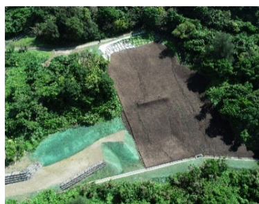
豊原地すべり測量設計 業務委託（R5） （中部土木事務所）
