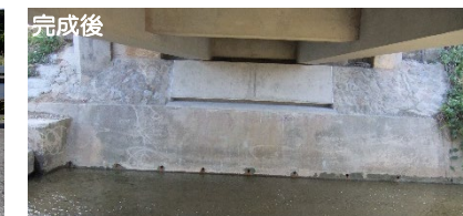
村道サトモ線 1 号橋 修繕設計業務（R3） （伊是名村役場）
