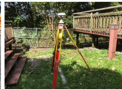
GNSS 測量 令和4年度沖縄自動車道喜舎場地区 幅杭設置測量業務 （西日本高速道路株式会社九州支社）
