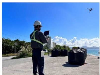
UAV測量業務 国道449号災害防除測量設計 業務委託（R4） （北部土木事務所）
