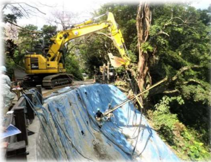
鉄筋挿入(削孔注入)
