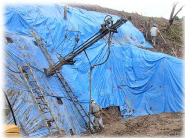
鉄筋挿入(削孔注入)
