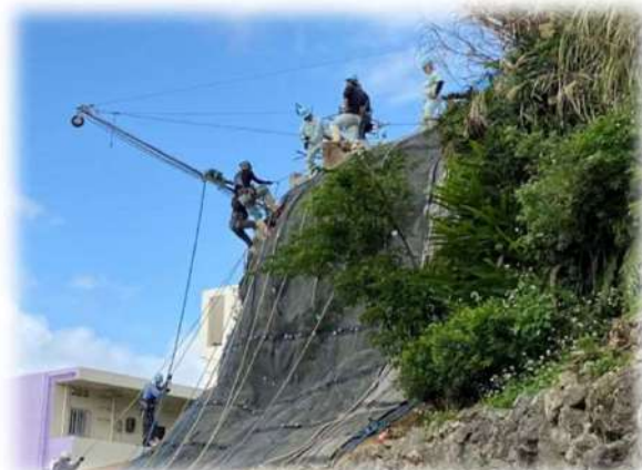
ウインチ使用人力施工
