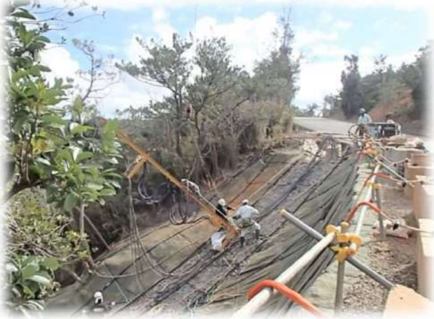
鉄筋直打ち工
