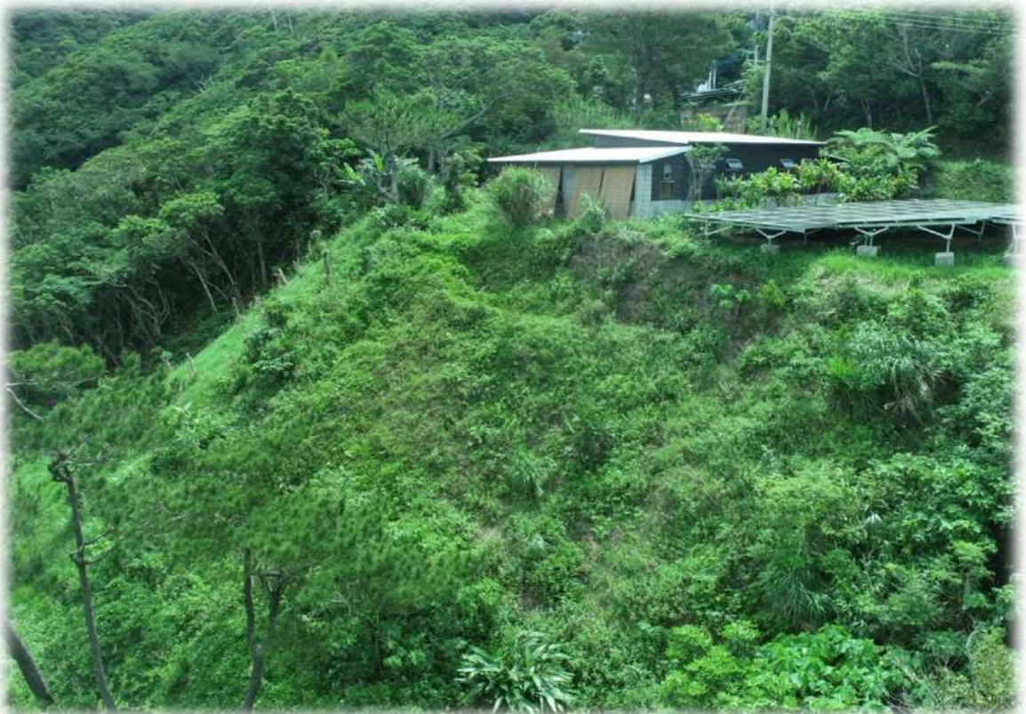
『フィット筋工法 ® 』で対策、4年後の緑化状況
