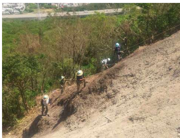
鉄筋直打ち工
