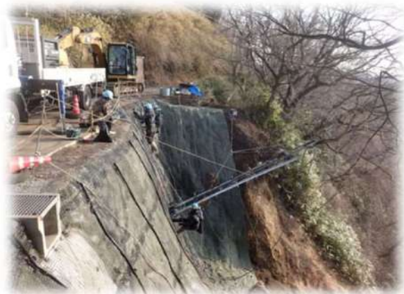
小型移動式クレーン使用
