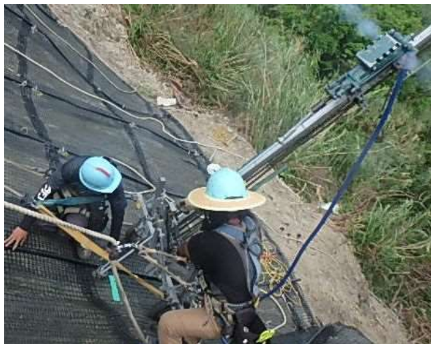
鉄筋直打ち工
