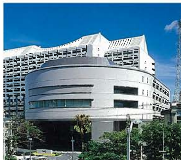
沖縄県議会棟(平成4年)
