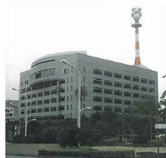
沖縄県警察棟(平成5年)
