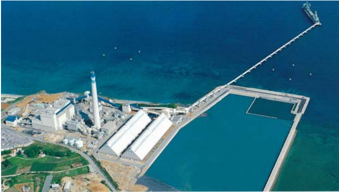
具志川火力発電所（平成7年）
