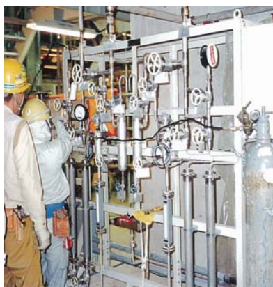
計装配管工事
