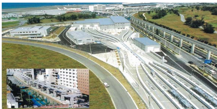
モノレール運営基地
