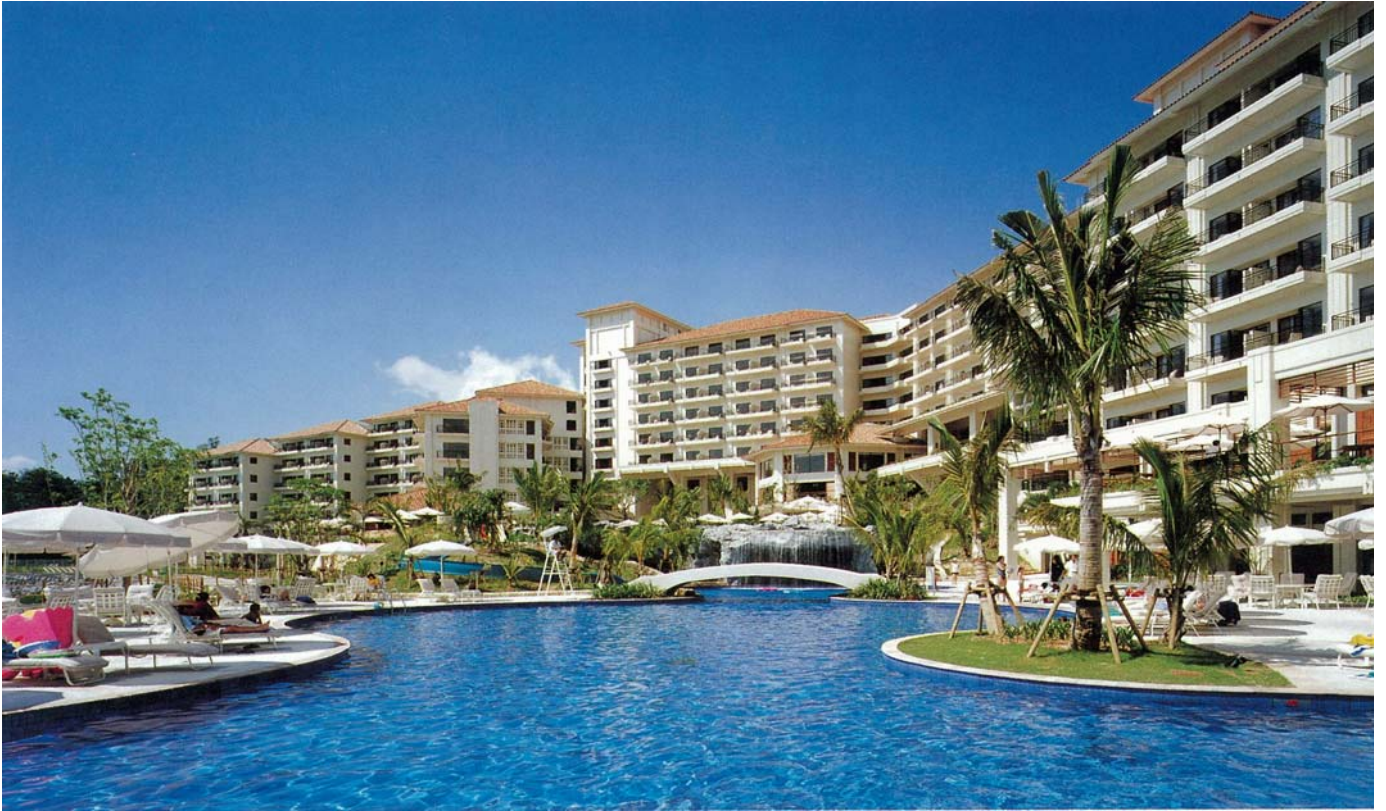
ザ・ブセナテラス(平成9年)
