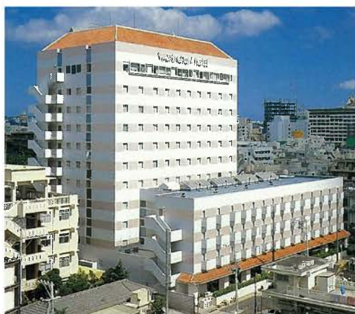
沖縄ワシントンホテル(昭和63年)
