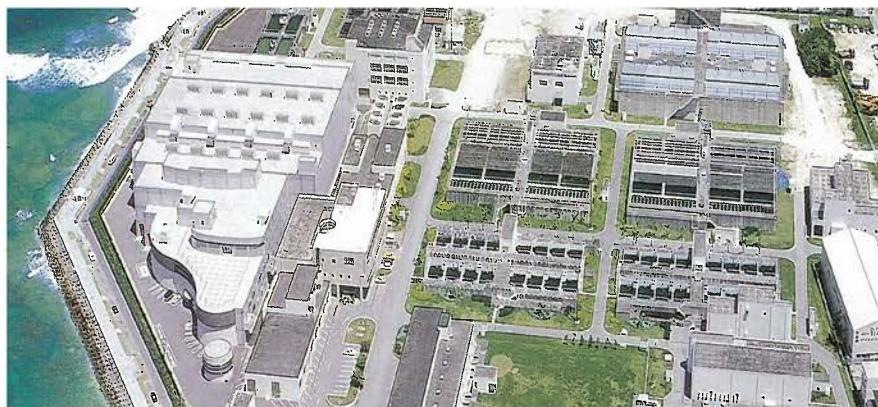
沖縄県海水淡水化施設
