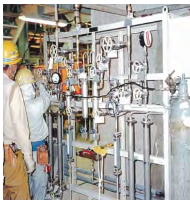
計装配管工事
