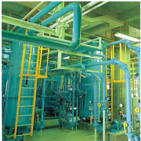
石川石炭火力発電所（純水製造装置）
