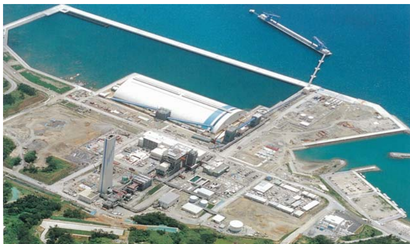
金武プロジェクト全景
