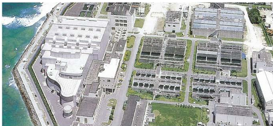
沖縄県海水淡水化施設
