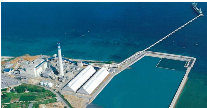
具志川火力発電所
