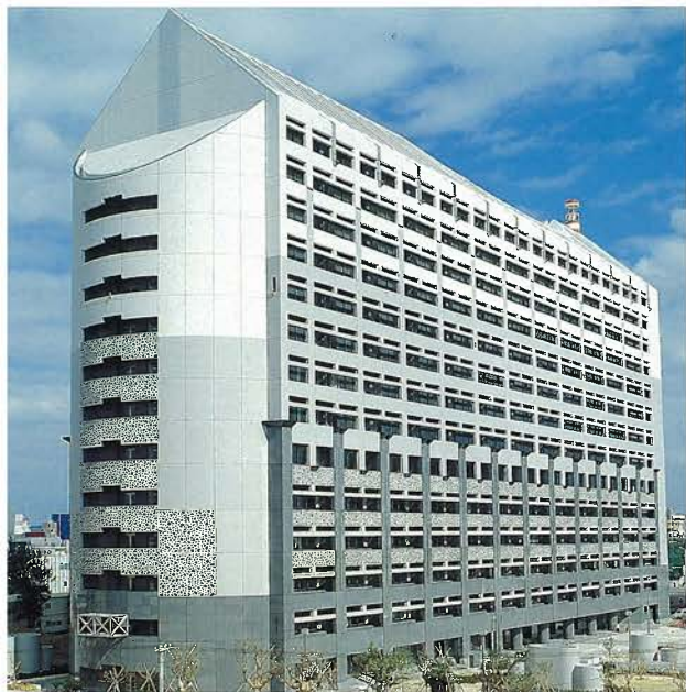
沖縄県庁舎行政棟(平成2年)
