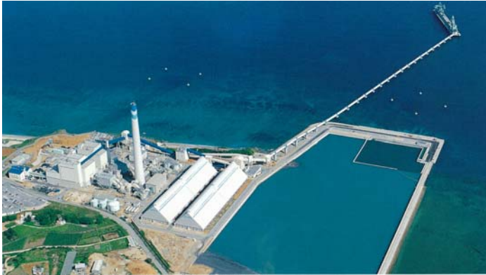
具志川火力発電所（平成7年）
