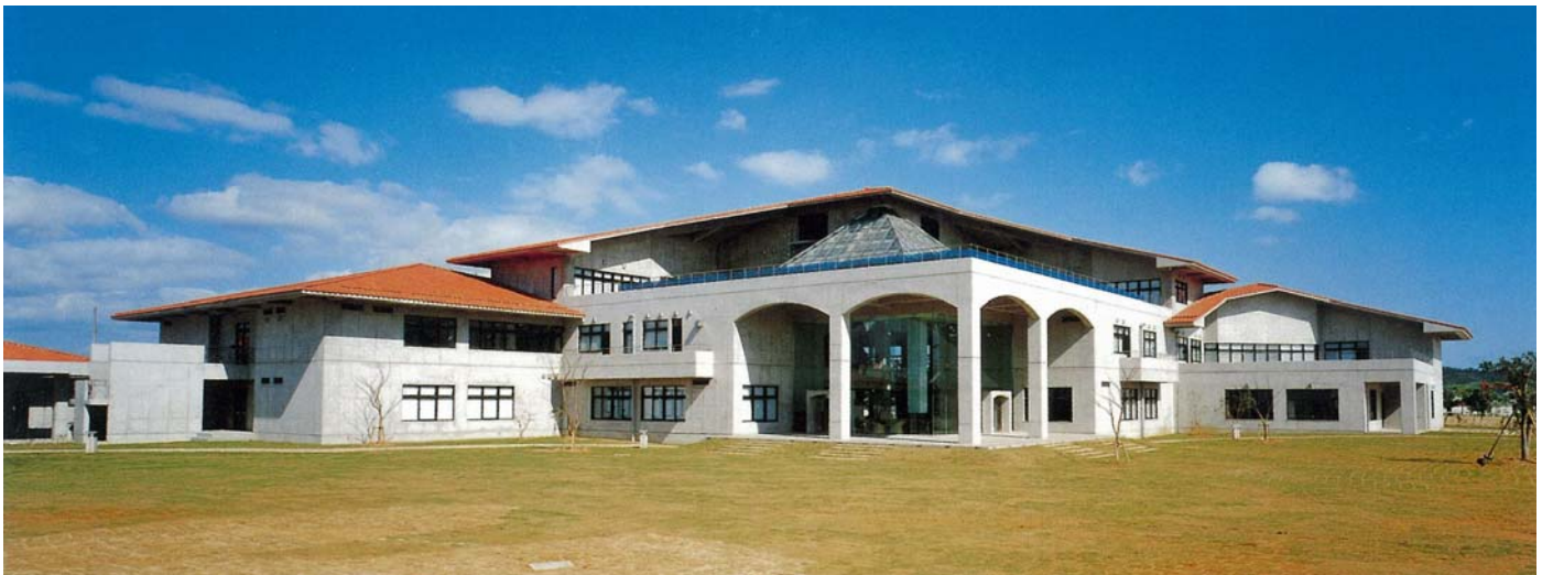
トロピカルテクノセンター(平成5年)
