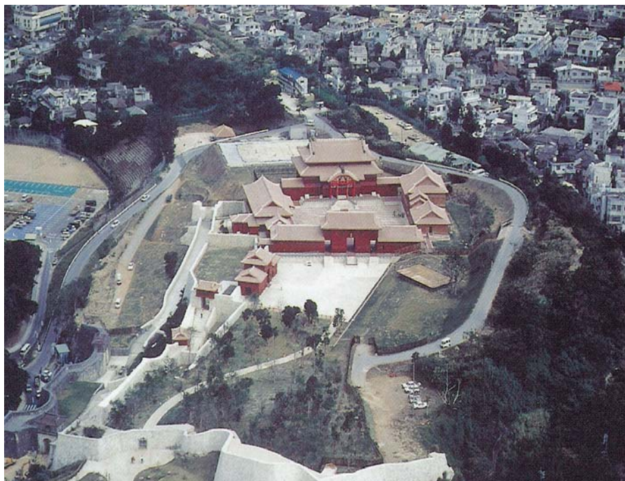
首里城正殿と広福門(平成4年)
