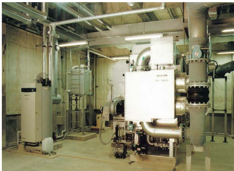
ザ・ブセナテラス機械室(平成9年)
