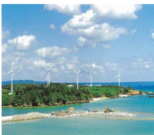
宜野座村風力発電所(平成10年)
