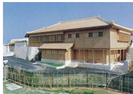
首里城二階殿(平成12年)
