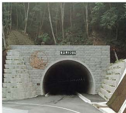
東江原トンネル
