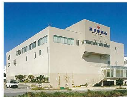
琉球新報製作センター(平成11年)
