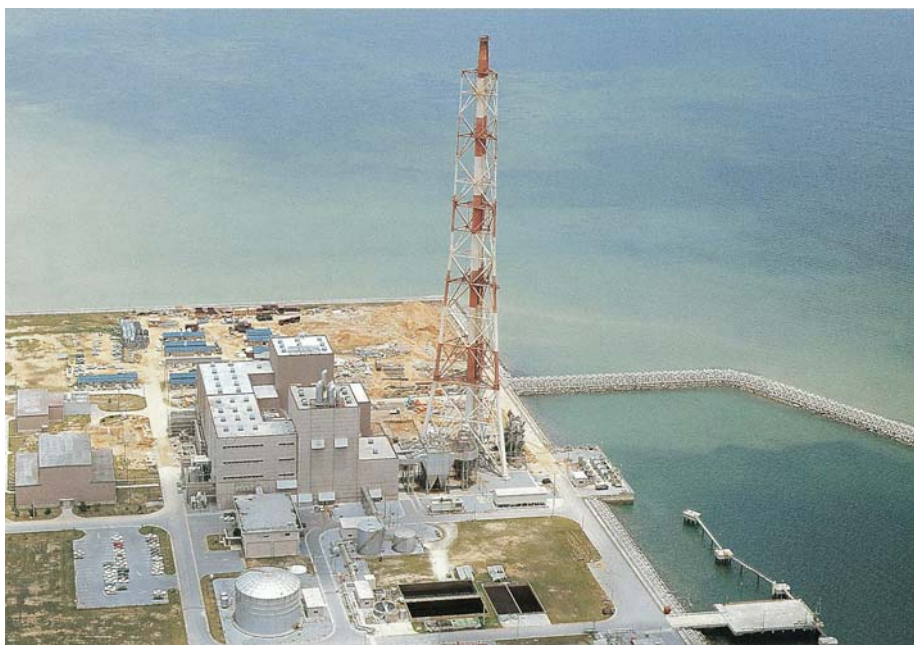
石川火力発電所
