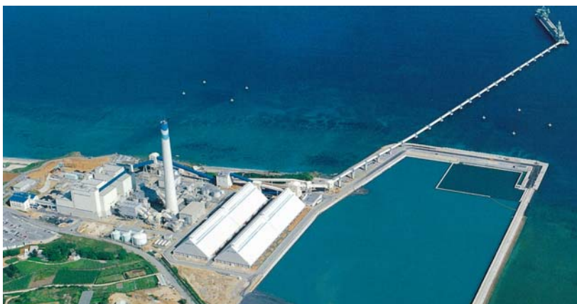
具志川火力発電所
