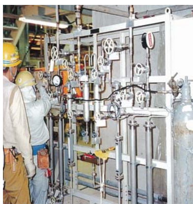
計装配管工事
