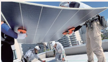
特許を取得した工法で、架台を用いずに直接接着することが可能です。
