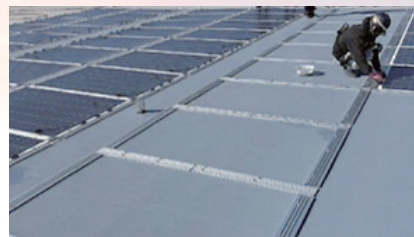
将来的な取替や屋根のメンテナンスを視野に入れ、フレームを用いた設置方法。こちらも特許を取得しています。
