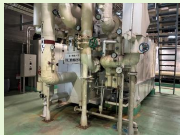
蒸気吸収式冷凍機 オーバーホール
