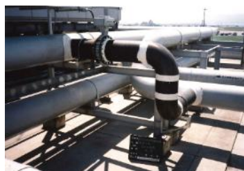
冷却塔行き配管バイパス管
