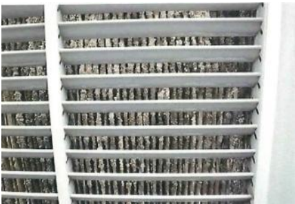
スケールの堆積した充填材
