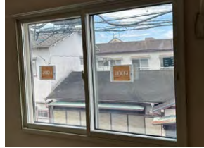
主居室の南側に内窓設置
