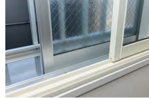
全住戸の内窓設置を実施
