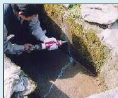
ひび割れの補修
