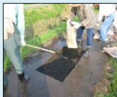
農道の部分補修
