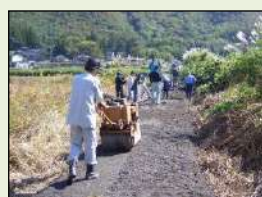
未舗装農道の舗装
