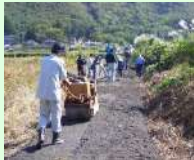
未舗装農道の舗装
