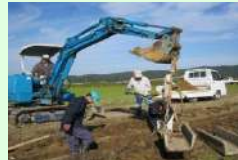
コンクリート水路の更新
