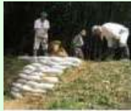
漏水箇所の補修
