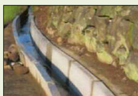
素堀り水路からの更新
