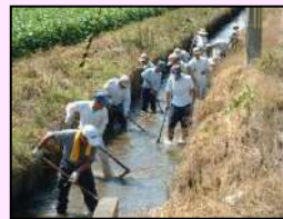
水路の泥上げ
