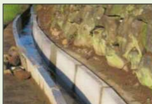
素堀り水路からの更新
