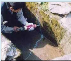
ひび割れの補修
