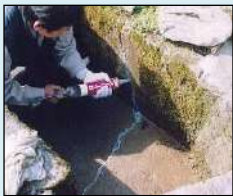
ひび割れの補修
