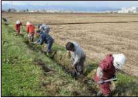
水路の泥上げ
