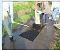
農道の部分補修
