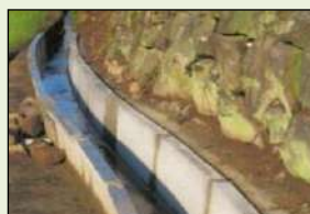
素堀り水路からの更新
