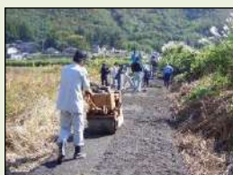
未舗装農道の舗装
