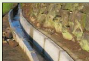
素堀り水路からの更新
