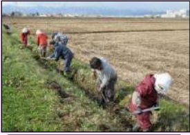
水路の泥上げ
