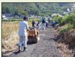
未舗装農道の舗装
