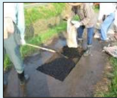
農道の部分補修
