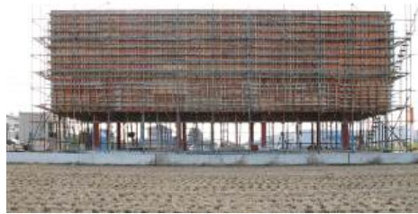
1 齊藤正毅工房事務所『イスノキ』半直営工事 施工写真
