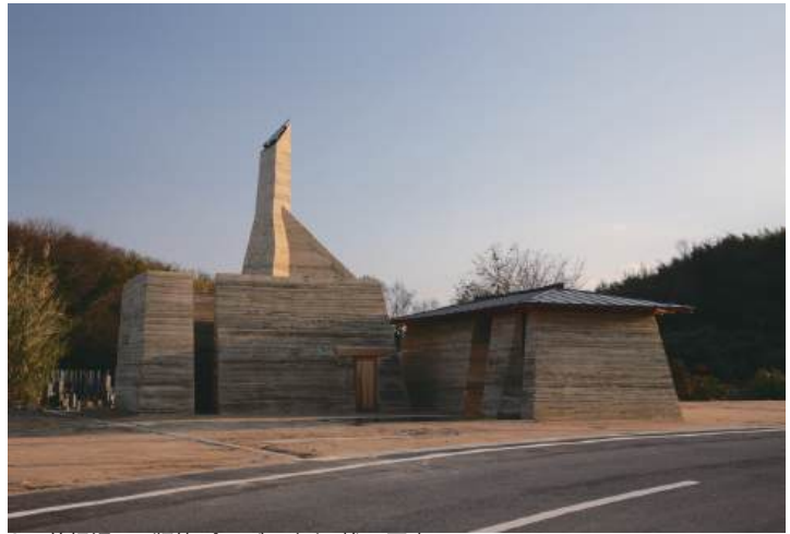
9 善根湯 × 版築プロジェクト 竣工写真
