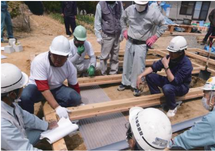
6 ZENKON 湯 現場写真
