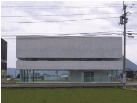
2 齊藤正毅工房事務所『イスノキ』竣工写真
