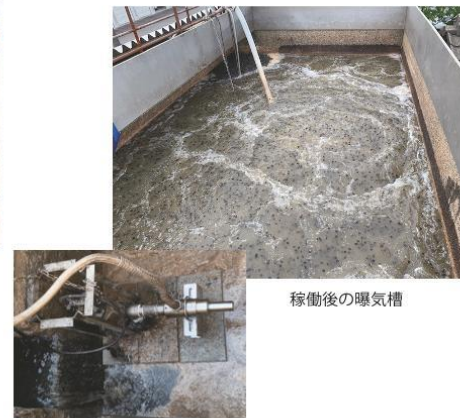
オゾン反応槽の MNB 装置
