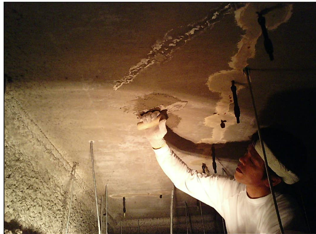
研り落とし＋鉄筋錆止＋下地補修
