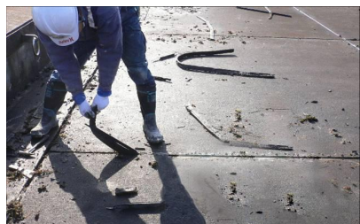
高圧洗浄・下地処理
