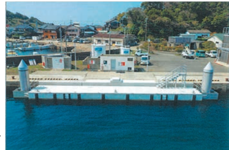
令和7年3月に竣工した青島漁港浮体式係船岸→
