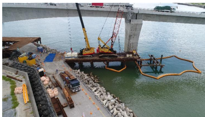
浦添市 仮栈橋撤去工事（南部国道発注）
