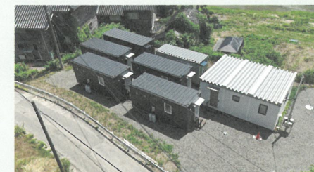
認定NPO法人ジャパン・プラットフォーム様からの助成金を活用し、輪島市や一般社団法人日本モバイル建築協会などと連携し、町野町にモバイルハウスを設置(輪島市)。
