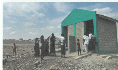
設置した公衆トイレ。男女3基ずつ、障がい者用個室付き。
