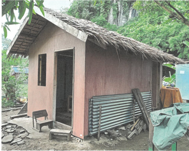
壁の修復を終えた家。今後トタンを屋根に取り付け、再び暮らせる住まいへと整えていく。
