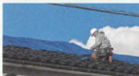
技術系ボランティアと協力した屋根のシート張り。
