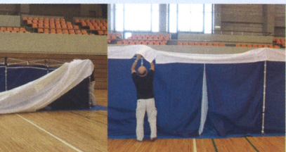
2棟設置後、補強パイプを連結します
