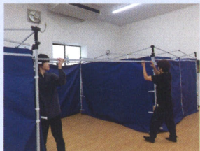
2棟設置後、補強パイプを連結します
