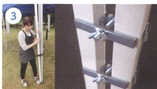
3 専用支柱を立て、テント支柱に連結具で上下2カ所を固定連結します。
