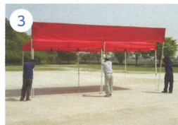
3 3人で支柱を立てフックネジに取り付けます。
