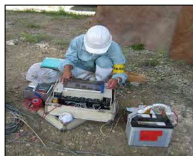
記録測定状況
