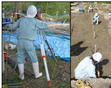
探査孔位置出し状況
