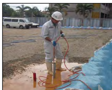
鉛直探査状況
