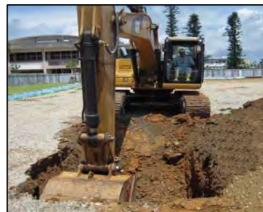
重機併用による掘削状況
