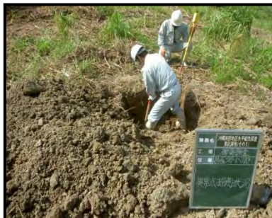
確認掘削状況
