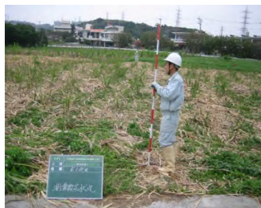
測線設定状況
