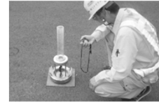
現場透水試験
