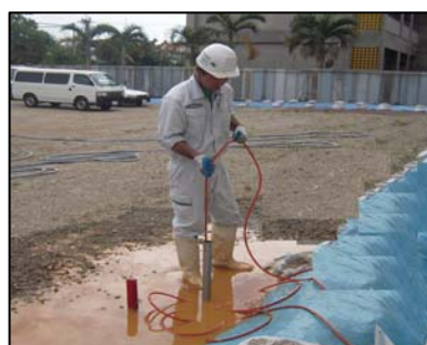
鉛直探査状況
