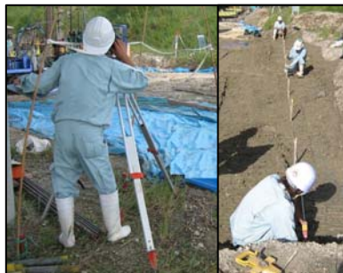
探査孔位置出し状況
