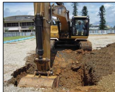
重機併用による掘削状況
