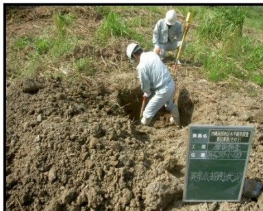
確認掘削状況
