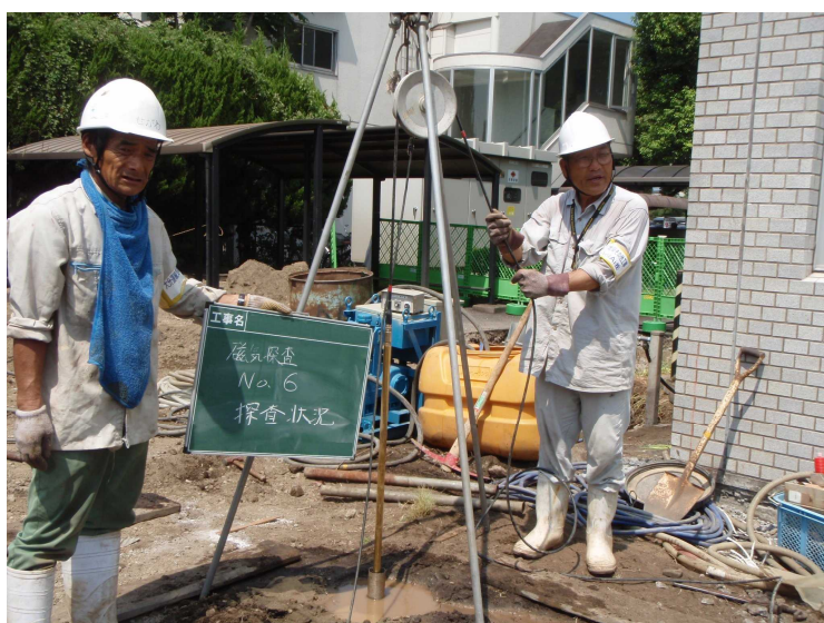
鉛直探査状況
