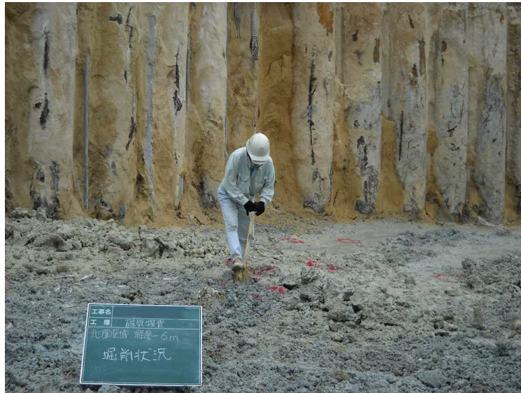
異常点の人力掘削状況
