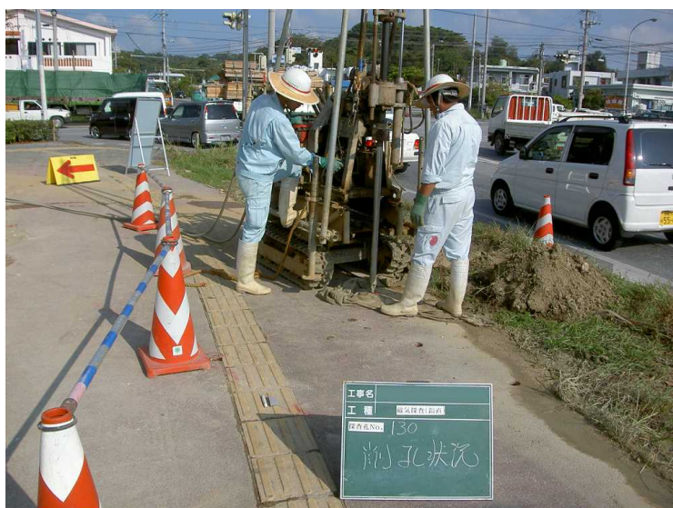
ボーリングマシンによる掘進状況
