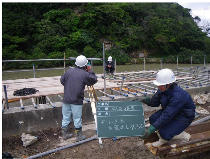
測量状況（鉛直探査）
