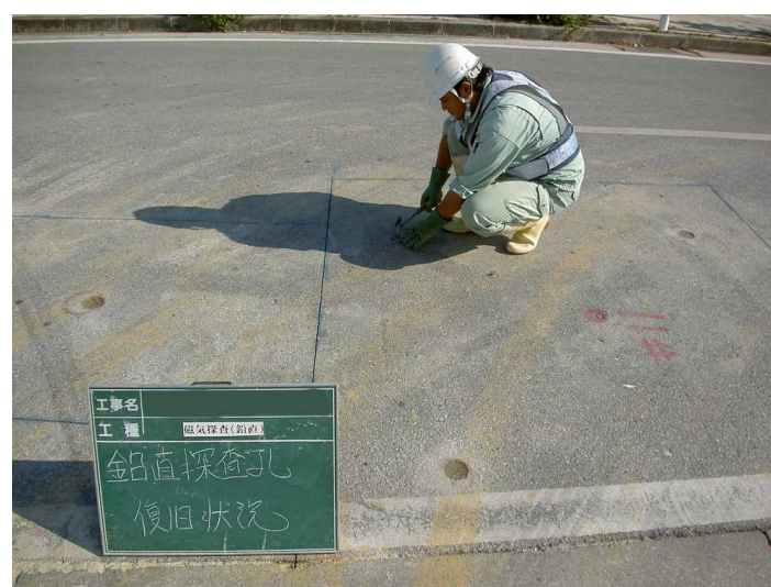
探査孔の埋戻し
