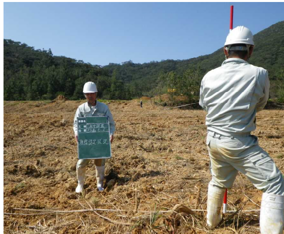
測線設定状況
